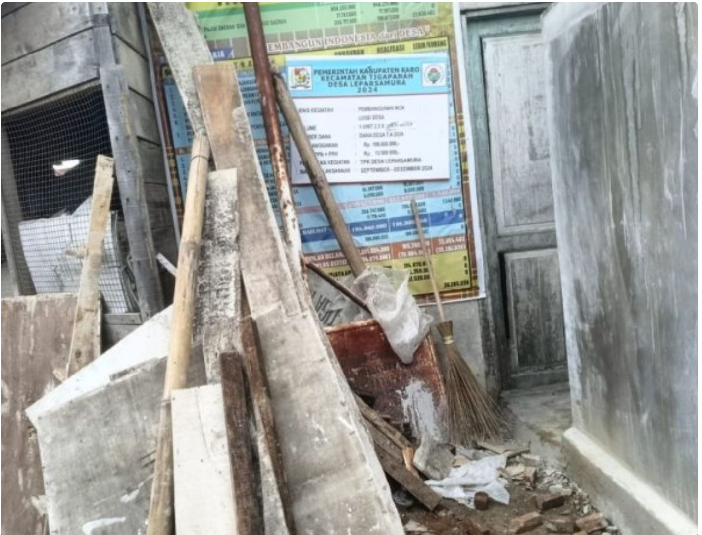
Bangunan MCK Desa Lepar Samura, Kecamatan Tigapanah, Kabupaten Karo Telan Dana Desa Ratusan Juta Rupiah
